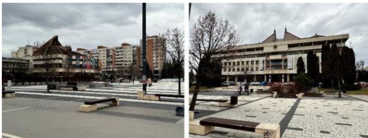
Figura 16 - Exemple de construcții specifice urbanului aparținând stilului Modernist-Socialist din municipiul Miercurea Ciuc Sursa: Autori studiu istoric de fundamentare
