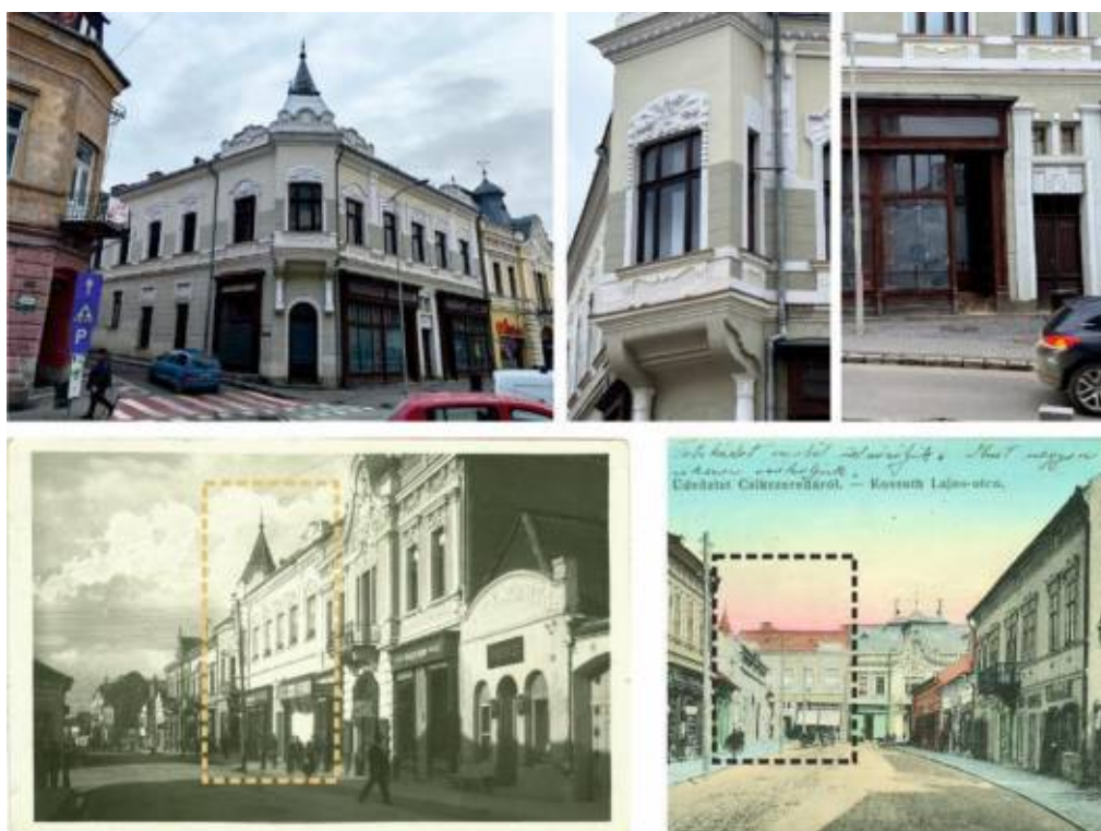
Figura 137 - Clădire – Strada Petofi Sandor nr. 1
