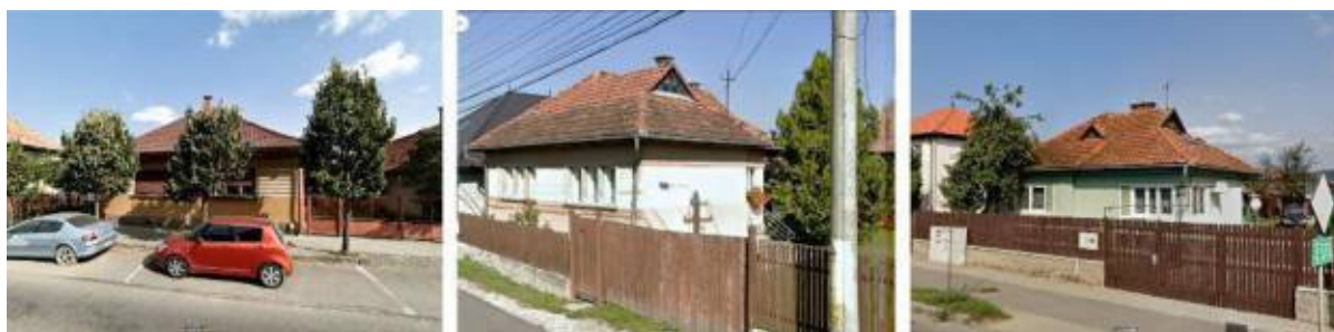
Figura 8 - Exemple de construcții tip din municipiul Miercurea Ciuc Sursa: Google Street View
