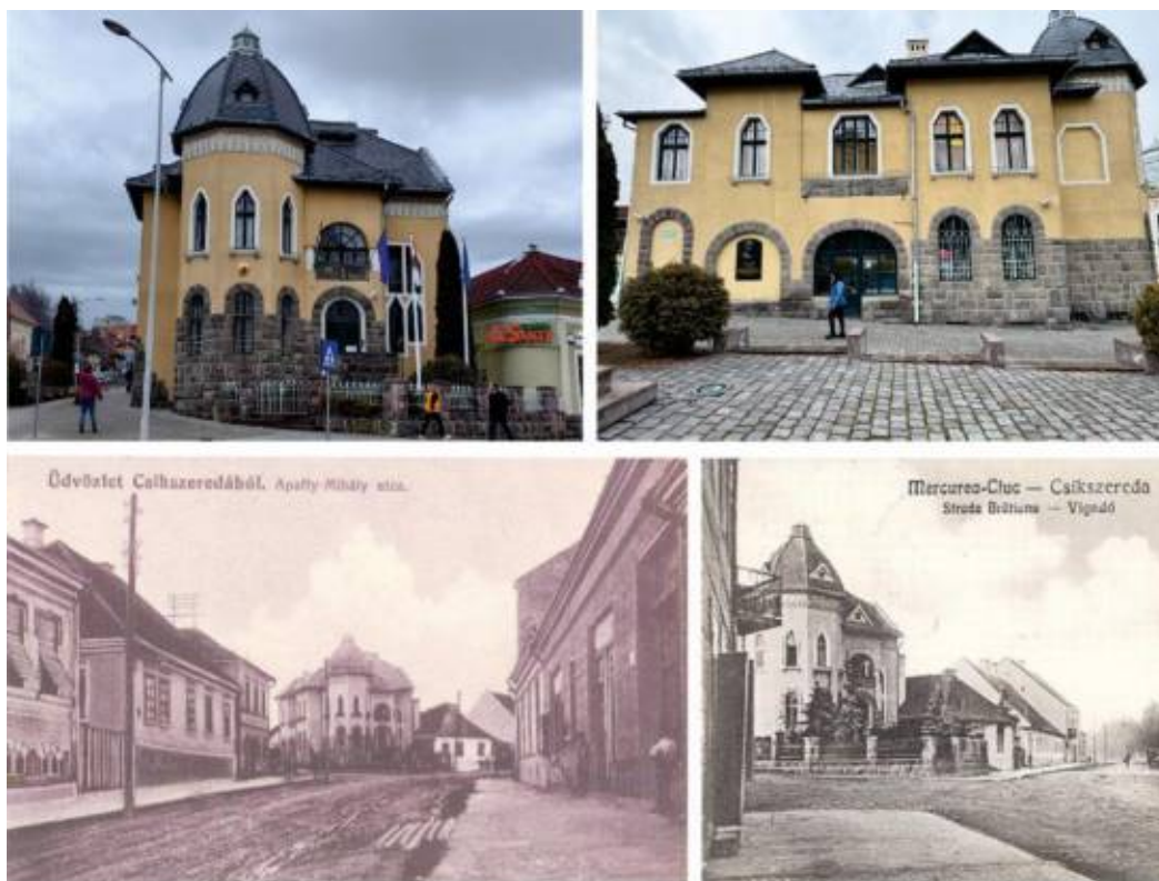
Figura 134 - Clădire – Strada Petofi Sandor nr. 45
