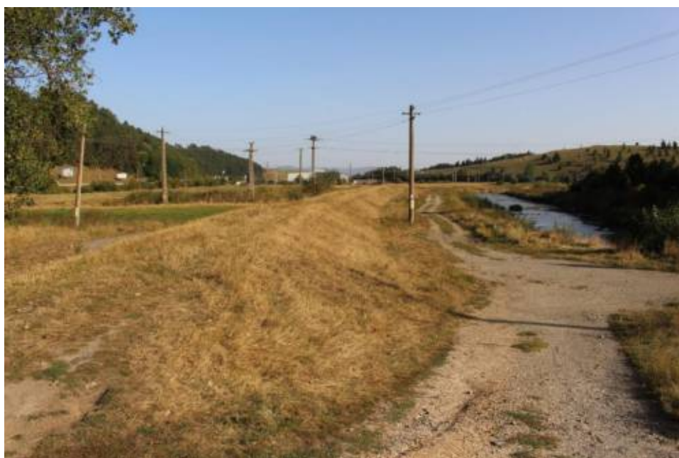
Figura 96 – Dig de protecție la viituri pe râul Olt
